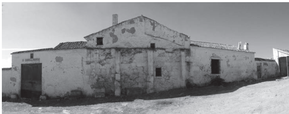
Lateral Noreste. La zona central del muro, corresponde con el muro de la sala de oración.
