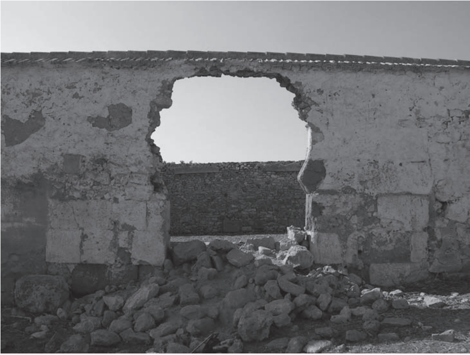
Una de las puertas del patio, que conserva parte del dovelaje del arco de herradura.
