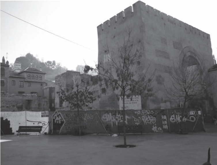
Fig. 2. Puerta exterior y corrales del castillo de la Puerta de Elvira.
