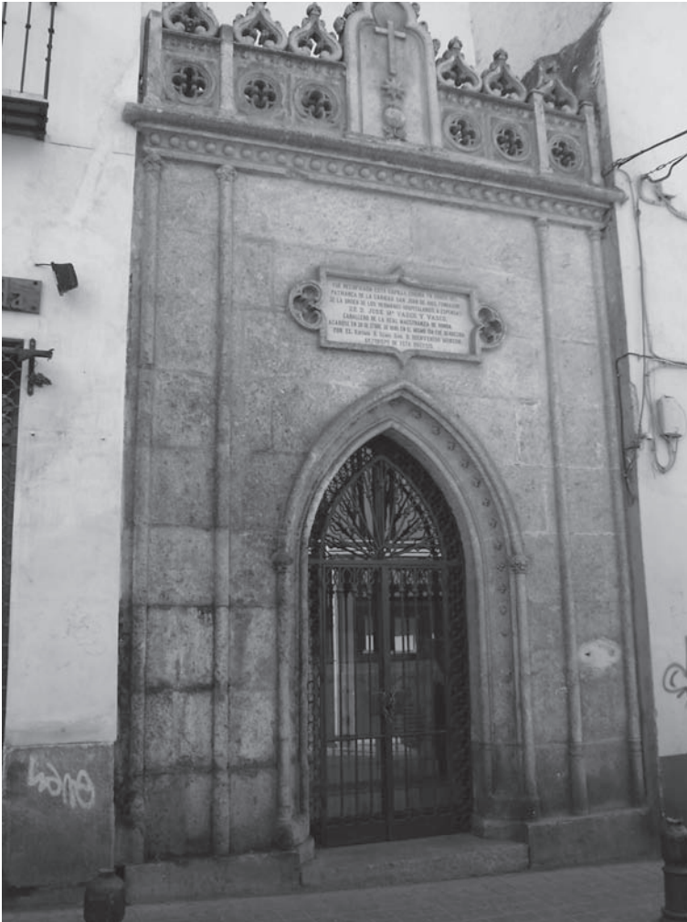
Fig. 4. Caja de una de las hojas del arco exterior del siglo XI, que daba a la calle Elvira, convertida en Capilla de San Juan de Dios en el siglo XIX.
